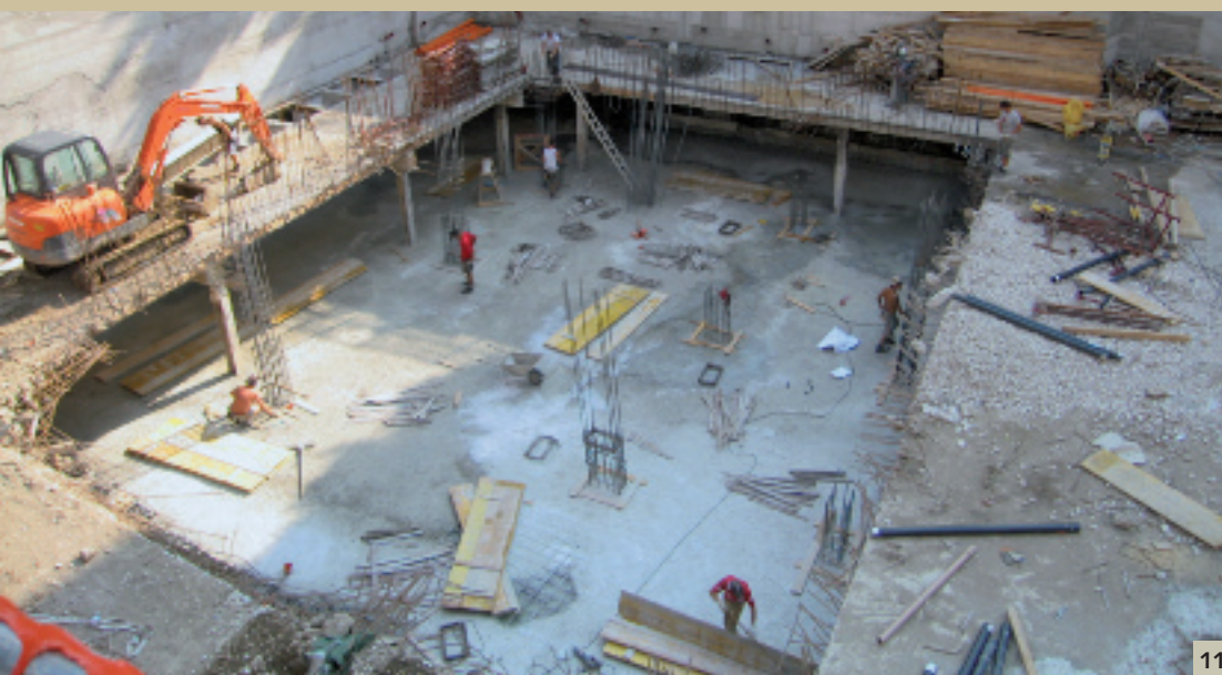
7. Operazioni di sbancamento con piazzola intermedia in via Tevere. 8. Vista dei pilastri provvisori in acciaio in via Como. 9. Vista dal basso del piano di appoggio della gru in via Sacchi. 10. Completamento delle solette realizzate in prima fase in via Tevere. 11. Soletta di contrasto al secondo livello interrato di piazza Ledro.
