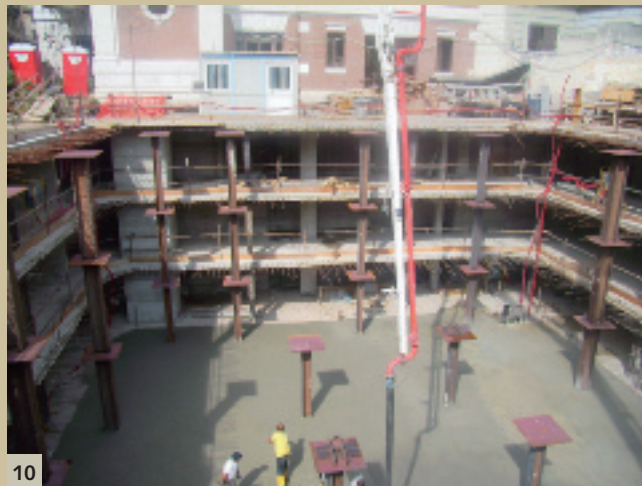
7. Operazioni di sbancamento con piazzola intermedia in via Tevere. 8. Vista dei pilastri provvisori in acciaio in via Como. 9. Vista dal basso del piano di appoggio della gru in via Sacchi. 10. Completamento delle solette realizzate in prima fase in via Tevere. 11. Soletta di contrasto al secondo livello interrato di piazza Ledro.
