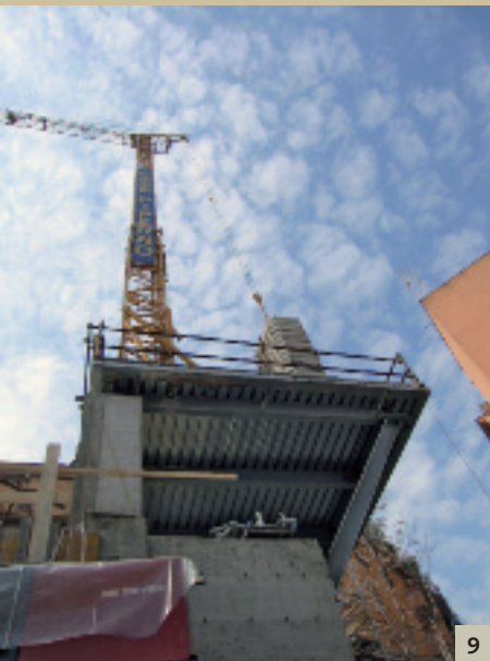
7. Operazioni di sbancamento con piazzola intermedia in via Tevere. 8. Vista dei pilastri provvisori in acciaio in via Como. 9. Vista dal basso del piano di appoggio della gru in via Sacchi. 10. Completamento delle solette realizzate in prima fase in via Tevere. 11. Soletta di contrasto al secondo livello interrato di piazza Ledro.
