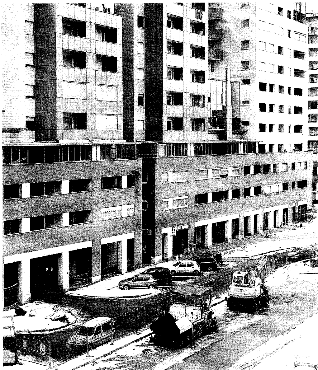
Lavori in corso per costruire la strada che dovrebbe servire i palazzoni dell'ex area Ingest
