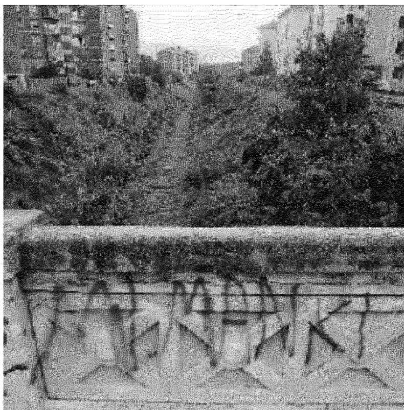
Il trincerone ferroviario lungo le vie Gottardo e Sempione scomparirà
