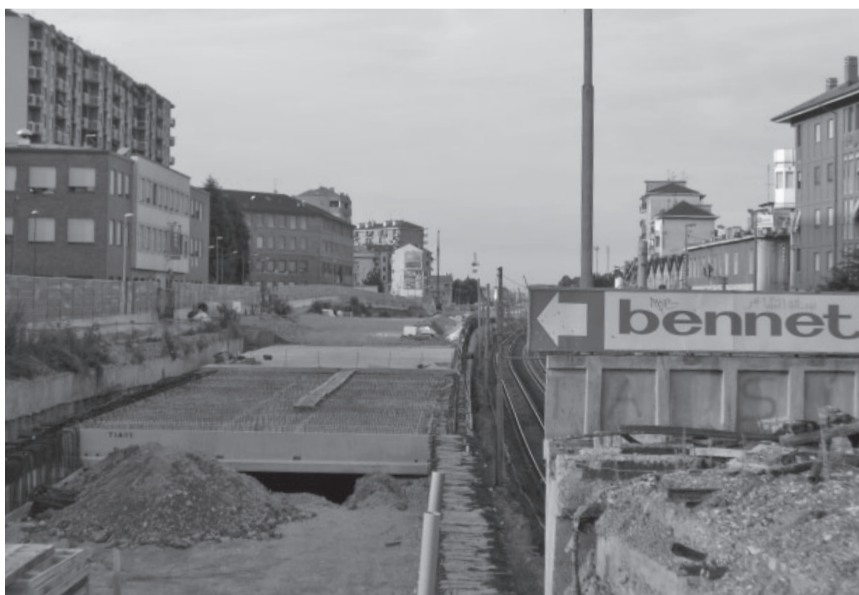
CORSO VENEZIA, AVANZA LA COPERTURA DEL PASSANTE
