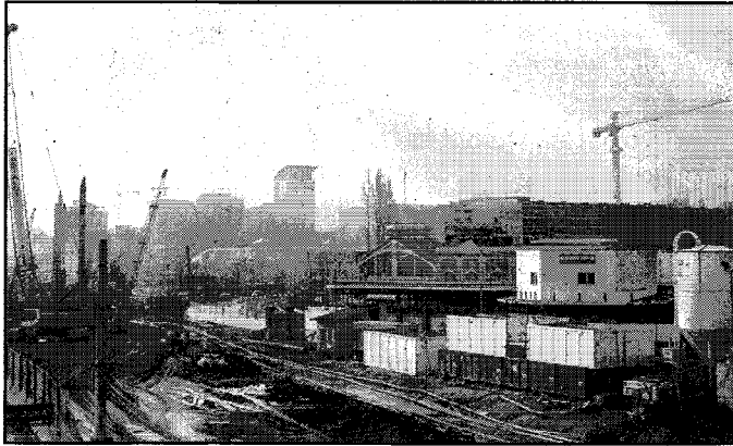
I lavori del Passante ferroviario di Torino presso stazione Dora
