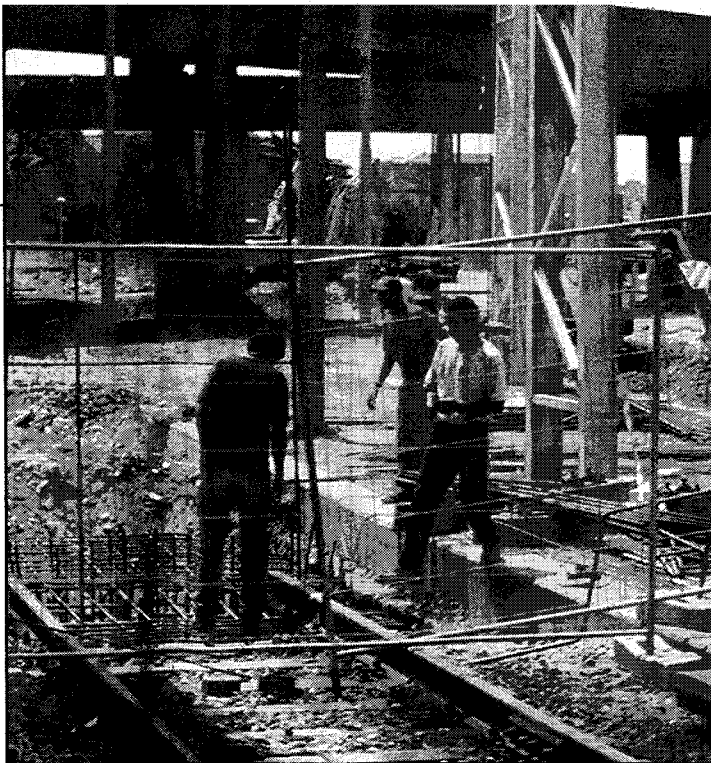
I lavori al Passante ferroviario alla stazione Dora iniziati a luglio
