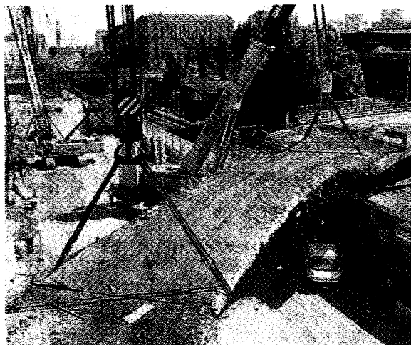
Le fasi dell'abbattimento della sopraelevata di corso Mortara: in alto a sinistra l'imbragatura del fondo stradale, a destra le gru ne rimuovono un'intera porzione; sotto, una veduta dell'area
